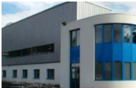
Ilustración 4 Nueva Planta de Tubos.
