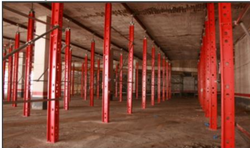
Imagen 6: Proceso de apuntalamiento – ‘BREC
