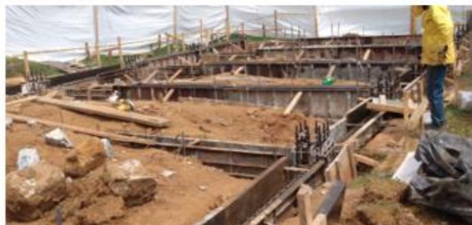
Fotografía 4 - Formaletas y figuración de acero
