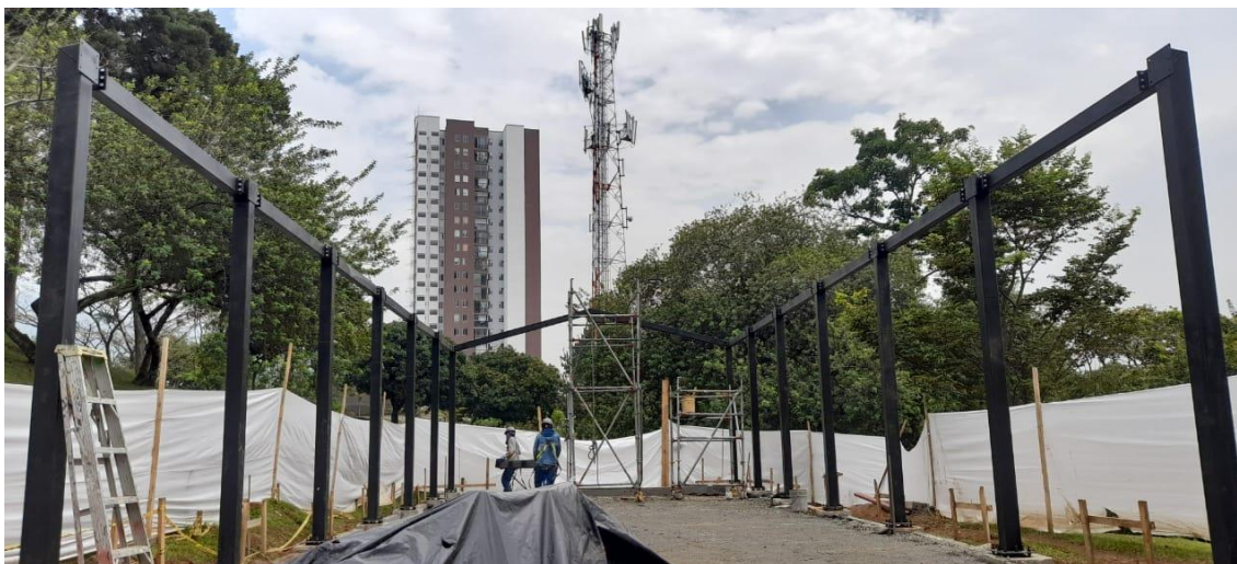
Fotografía 10 - Montaje vigas de amarre
