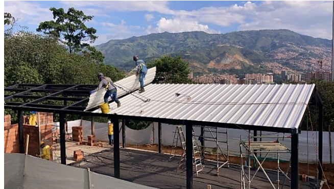
Fotografía 14 - Montaje de teja
