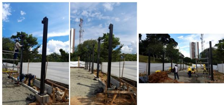
Fotografía 9 - Montaje columnas
