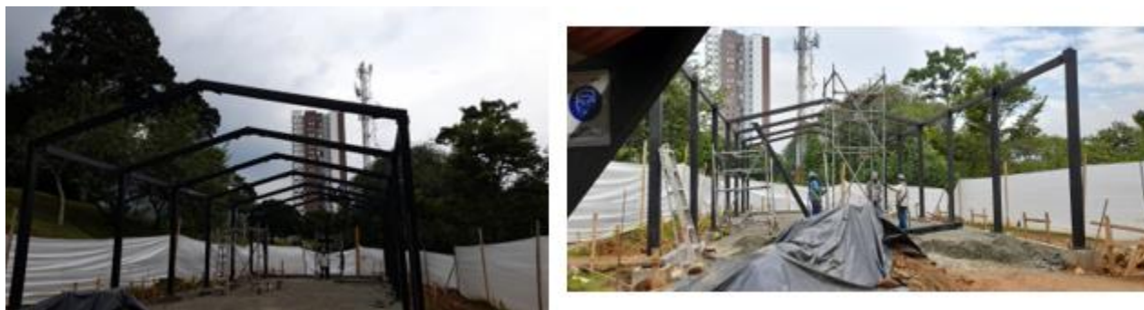
Fotografía 11 - Montaje vigas de cierre
