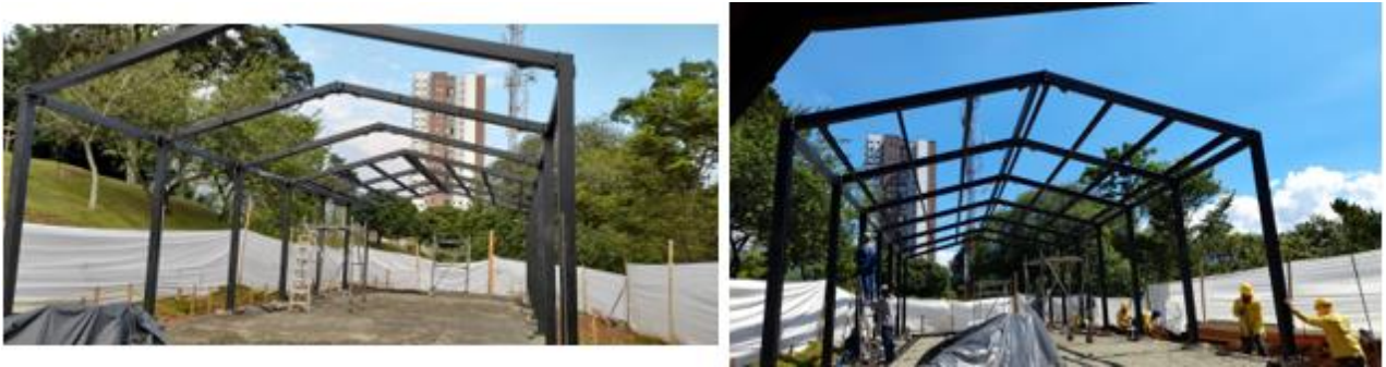
Fotografía 12 - Montaje de correas
