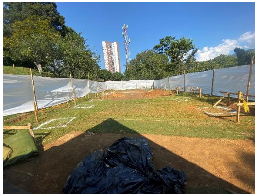
Fotografía 2 - Cerramiento perimetral y replanteo
