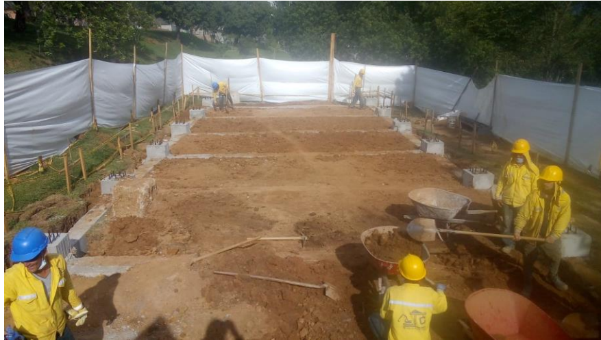
Fotografía 7 - Nivelación del terreno
