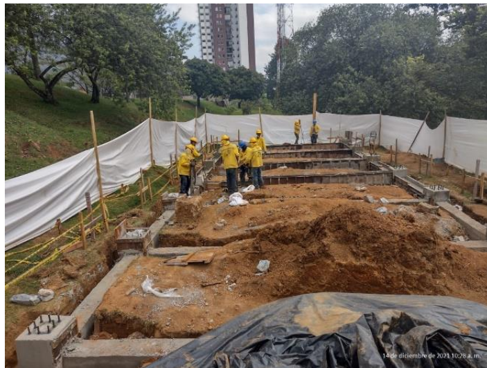
Fotografía 6 - Vaciado de vigas de fundación
