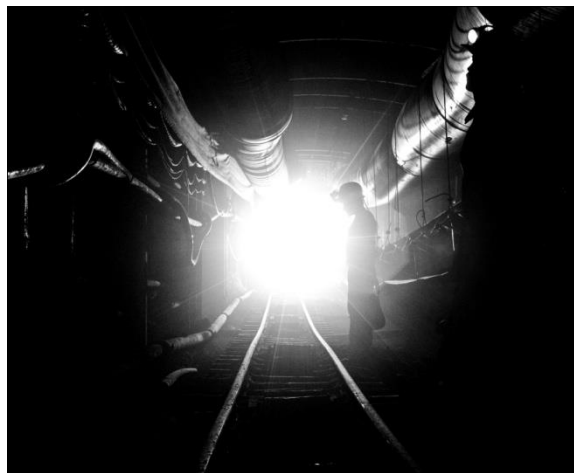
Minero en la vía férrea
