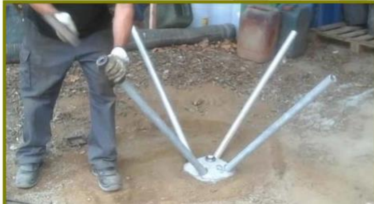
Figura 63. Hincado de tubos de forma manual
