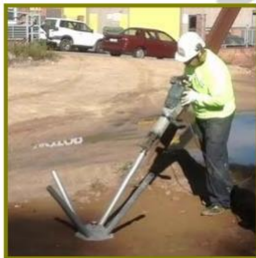
Figura 64. Hincado de tubos de forma mecánica
