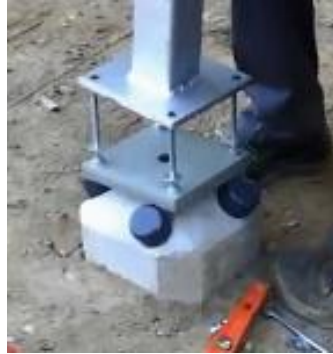
Figura 60. Ejemplo de conexión columna - Piloedre
