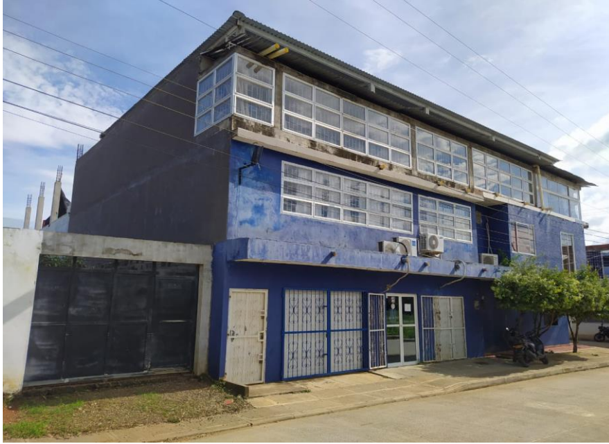
Figura 4 Edificio de cuatro plantas de la empresa Maranata Uniformes S.A.S.
