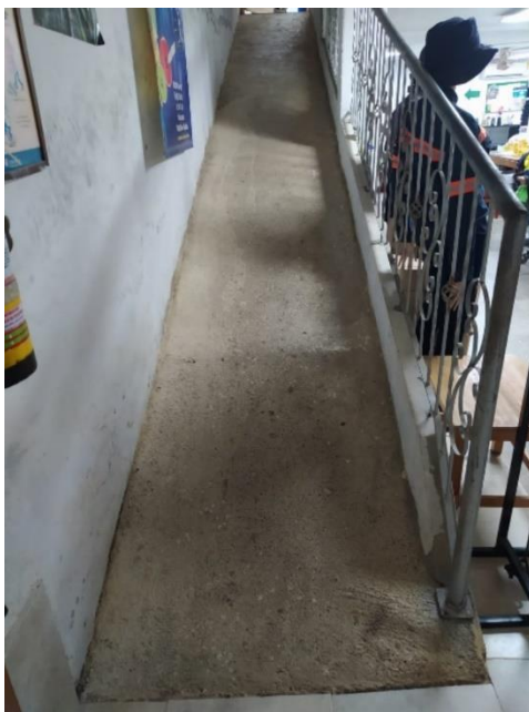
Figura 11 Rampa de acceso de materiales hacia la segunda planta del edificio de Maranata Uniformes S.A.S.
