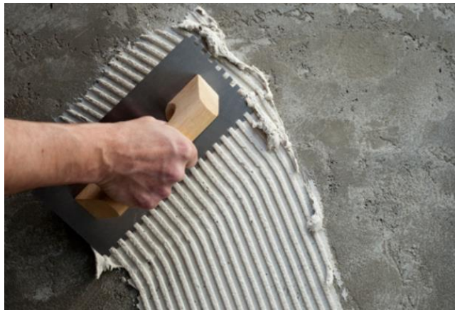
Figura 111. Aplicación de mortero seco
