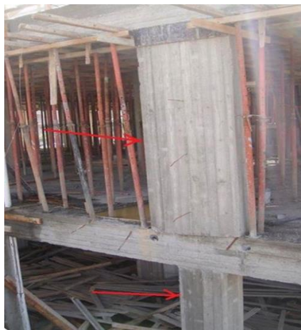
Figura 56. Cambio de sección en los elementos estructurales
