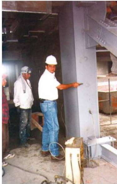
Figura 104. Encamisado de perfiles metálicos en columnas
