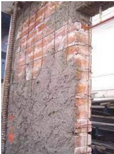
Figura 93. Encamisado de muro con malla electrosoldada
