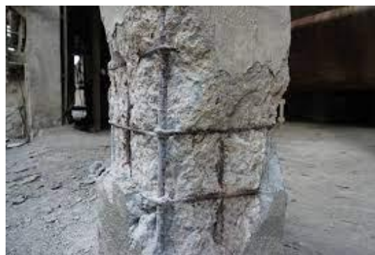
Figura 98. Preparación del elemento para sustituir hormigón afectado
