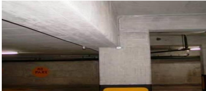
Figura 60. Excentricidad en elementos estructurales
