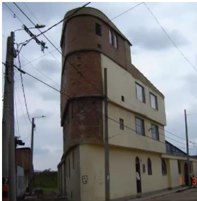
Figura 55. Cambio de sección en la estructura
