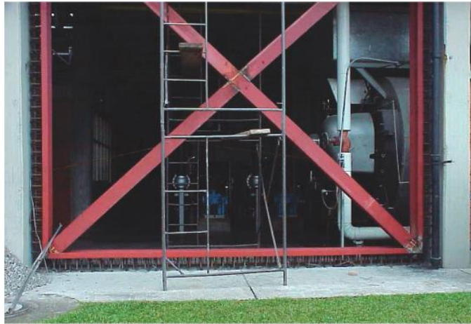
Figura 99. Arriostramiento con elementos metálicos
