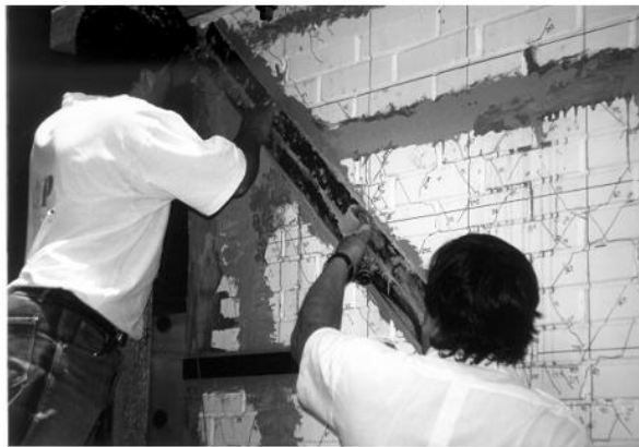
Figura 96. Colocación de fibras de carbono
