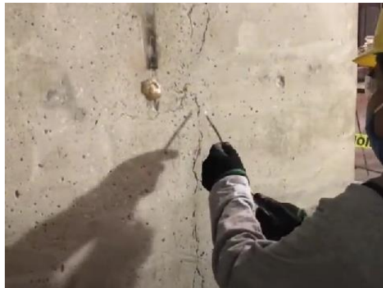
Figura 107. Inyección de resinas epóxicas
