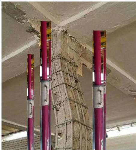
Figura 106. Apuntalamiento de columna para intervención
