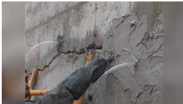
Figura 95. Inyección de morteros de cemento
