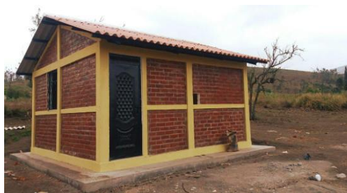
Figura 6. Vivienda en mampostería confinada
