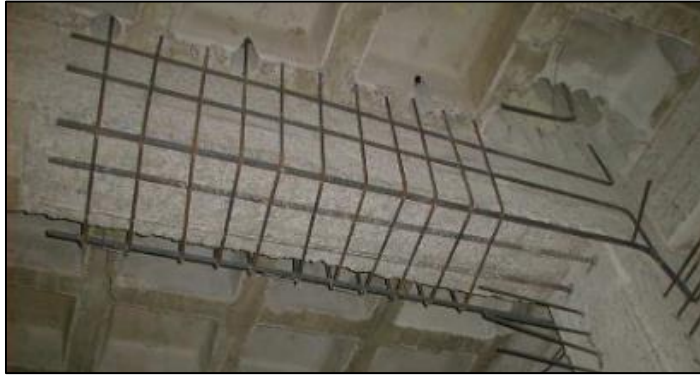
Figura 101. Encamisado en viga
