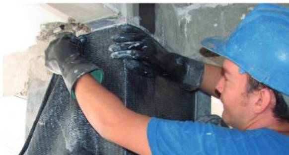
Figura 102. Recubrimiento con fibras de carbono
