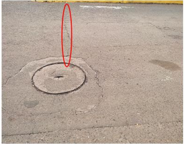
Fisuras Transversales
