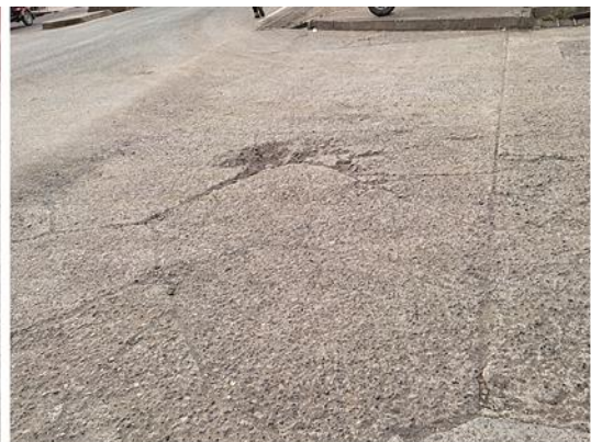
Grietas en Bloque o Fisuración Múltiple
