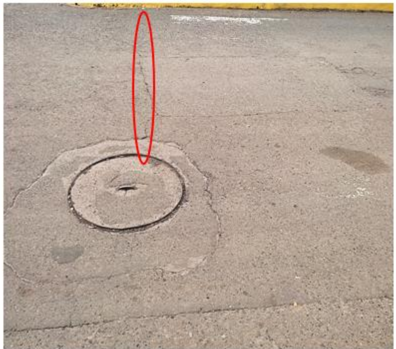
Ilustración 23. Fisuras Transversales
