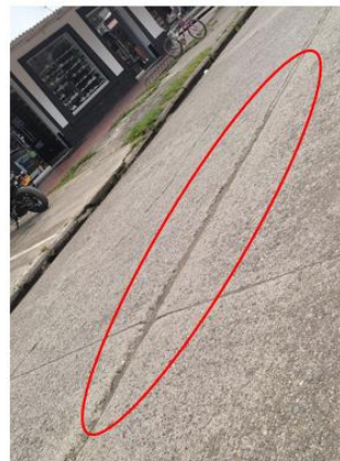
Separación de Juntas
