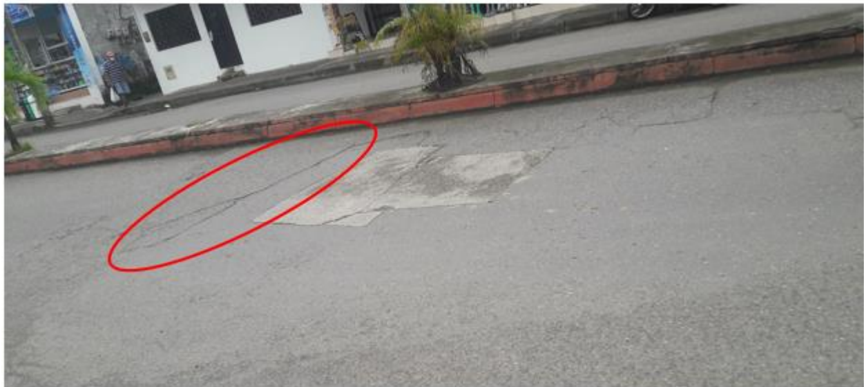
Ilustración 31. Fisuras Transversales
