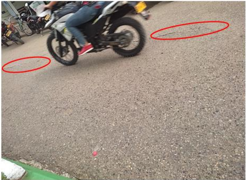
Ilustración 22. Fisuras Longitudinales
