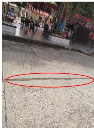
Separación de Juntas
