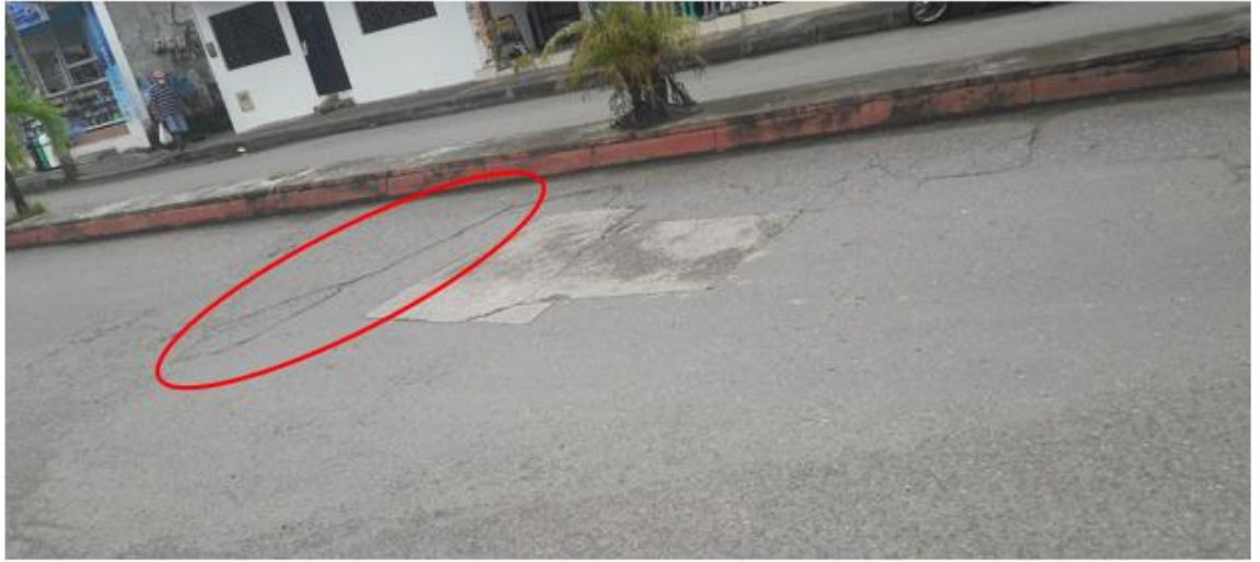
Fisuras Transversales
