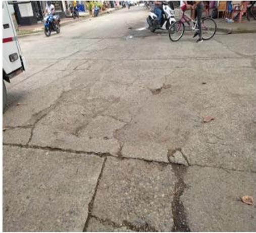
Grietas en Bloque o Fracturación Múltiple
