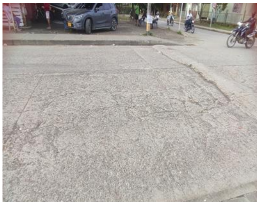
Grietas en Bloque o Fisuración Múltiple
