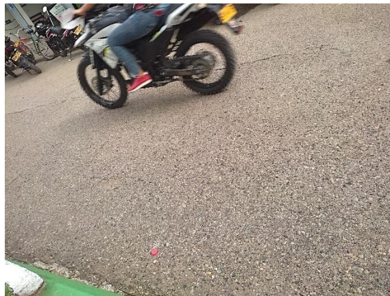
Fisuras Longitudinales
