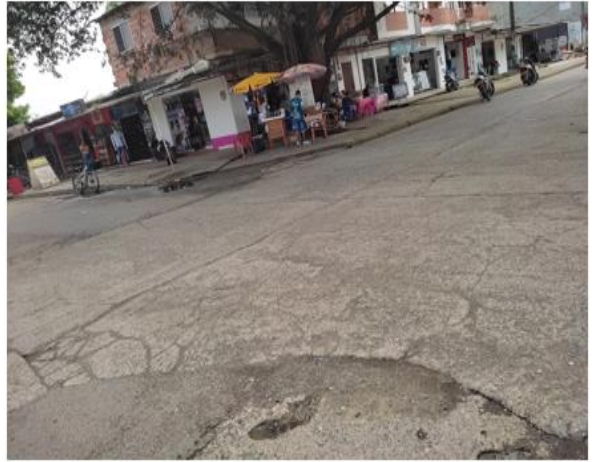
Grietas en Bloque o Fracturación Múltiple
