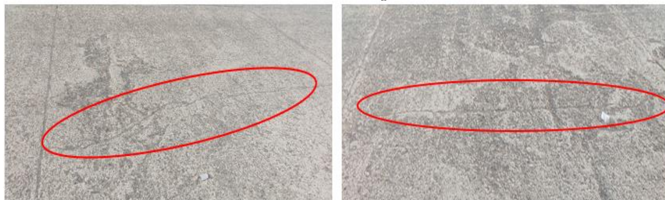
Ilustración 6. Grietas Longitudinales
