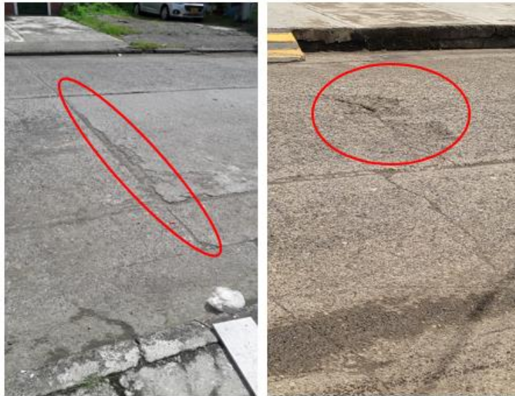
Ilustración 12. Descascaramiento
