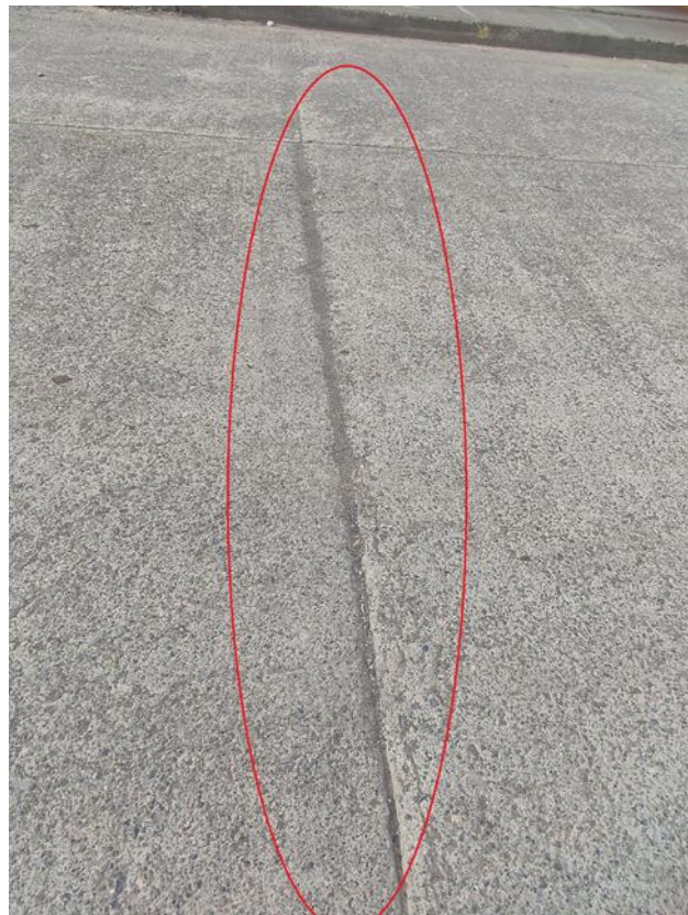
Separación de Juntas
