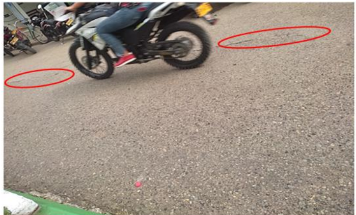
Fisuras Longitudinales
