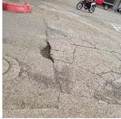
Fisuras Longitudinales
